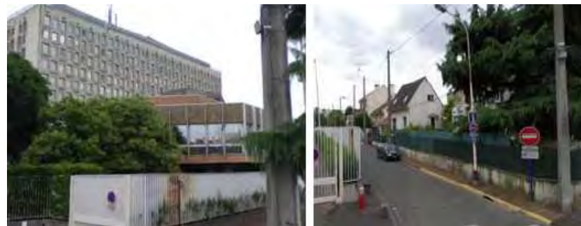
Site EDF vu depuis la rue de la Commune (avant démolition) et impasse Savry
