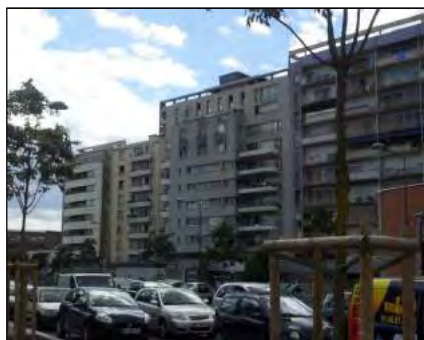
Collectifs alignés sur la RD7
