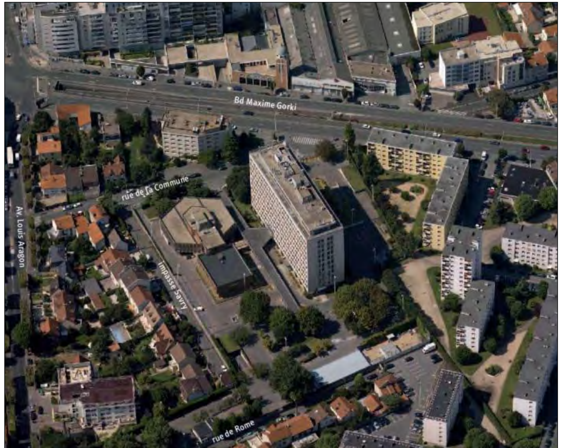
Le site EDF dans son environnement avant sa démolition
