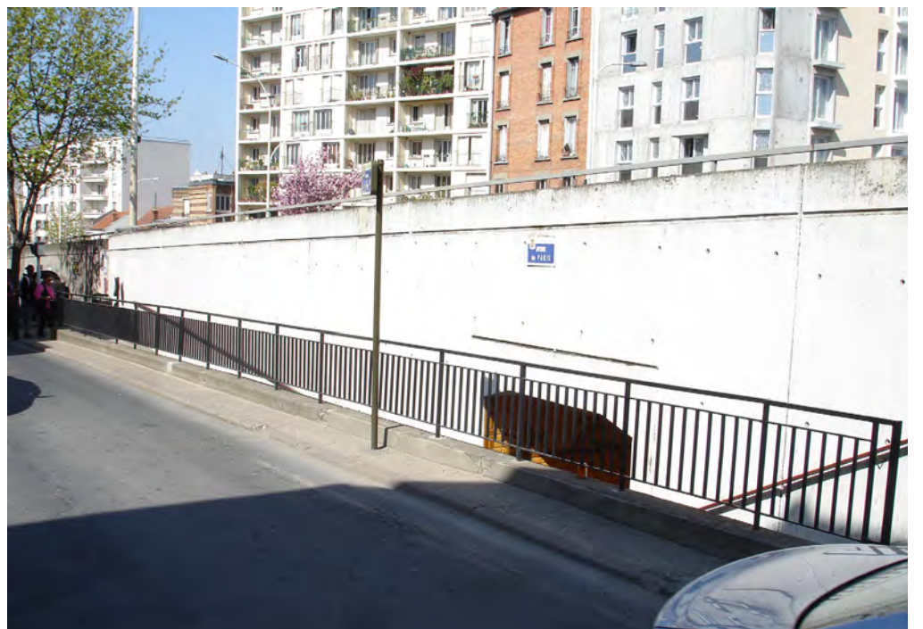
Les trémies de la RD7, une limite aux communications interquartiers
