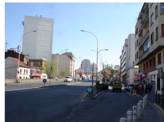
Entrée de ville Nord (2)
