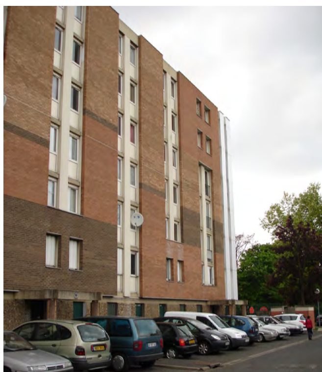
< Un quartier dégradé ne disposant pas d'espaces publics internes de qualité
