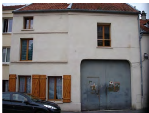
Maison rurale de bourg à plusieurs niveaux, avec porte cochère
