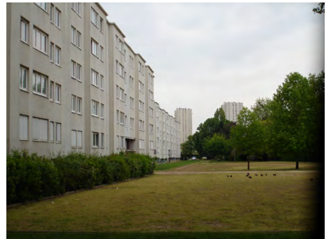
Espaces extérieurs - quartier Mermoz
