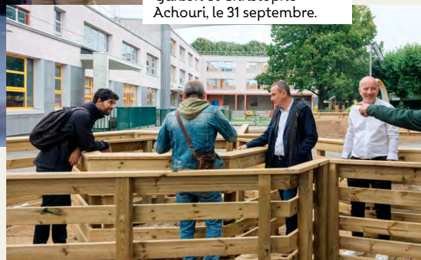
Visite du chantier de l'école Joliot-Curie avec Pierre Garzon et Christophe Achouri, le 31 septembre.
