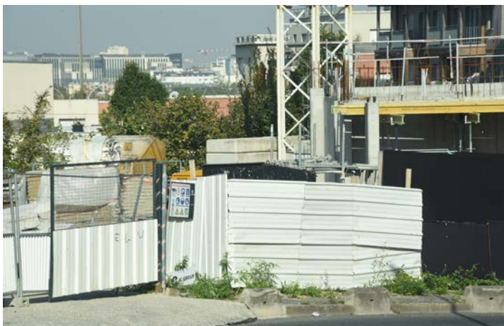
Les palissades permettent de sécuriser l'accès au chantier et jouent un rôle essentiel contre les nuisances visuelles. Leur bon entretien est donc primordial.
