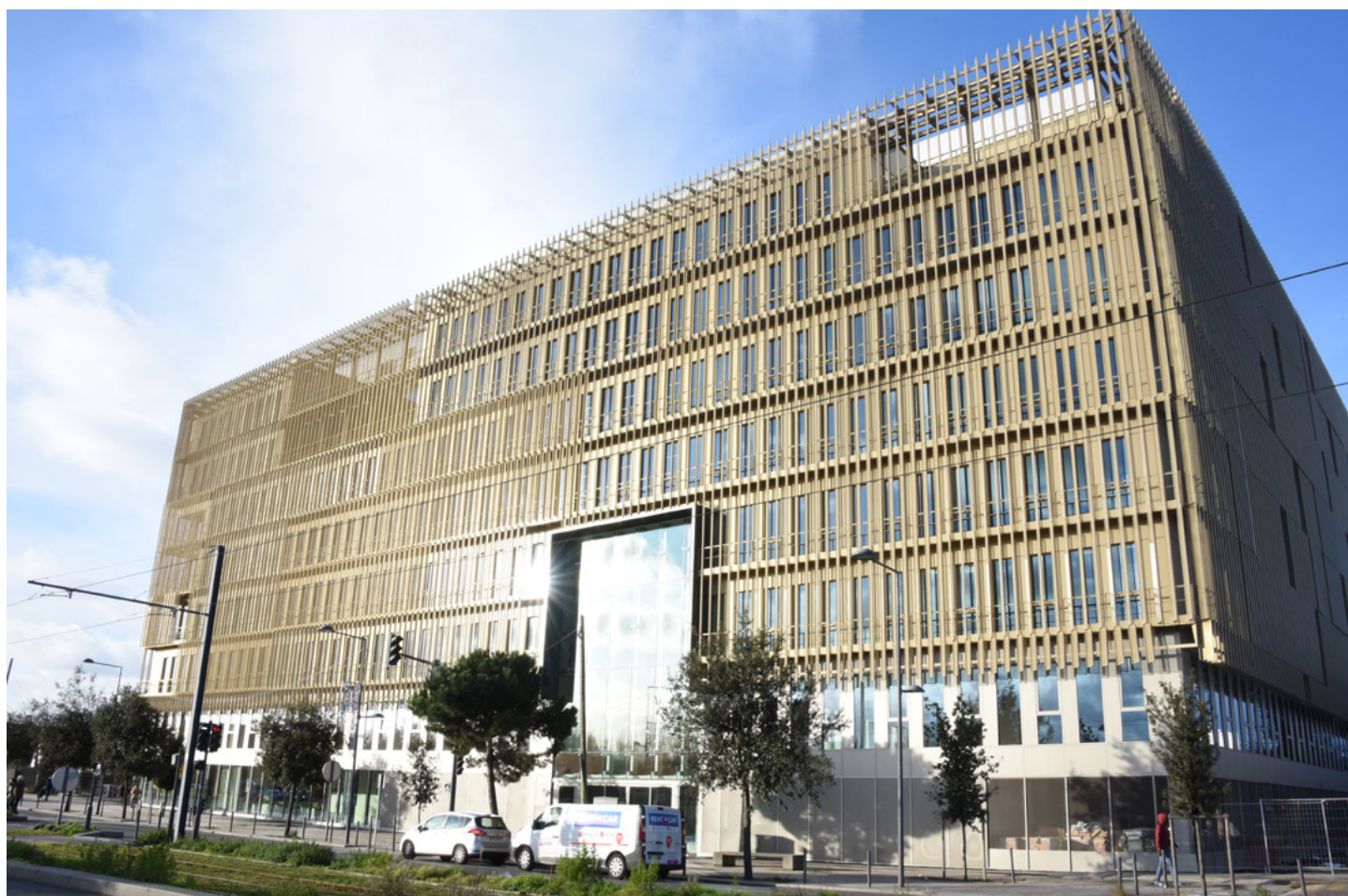
En façade, le jeu des panneaux métalliques crée des motifs et des transparences. L'entrée monumentale offre également une percée visuelle vers la rue Lamartine.
