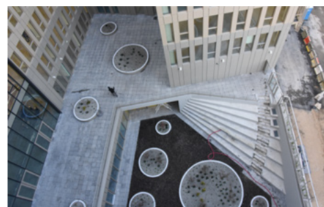
Côté rue Lamartine, dont les travaux de voirie sont en cours, un espace extérieur végétalisé jouxte le restaurant d'entreprise, en rez-de-jardin.
