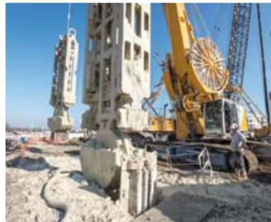
Une dalle de couverture est alors coulée en ne laissant qu'une ou plusieurs ouvertures par lesquelles hommes et machines passeront pour procéder au creusement et à l'évacuation des déblais. Cette méthode est recommandée en milieu urbain dense afin de limiter les nuisances sonores et les poussières mais est plus laborieuse.
